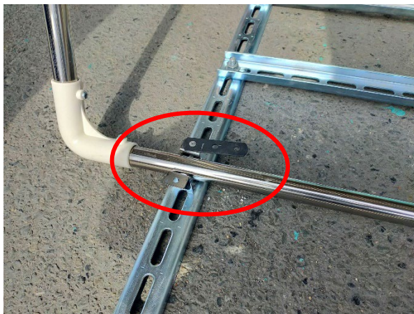
3. パイプを入れる
