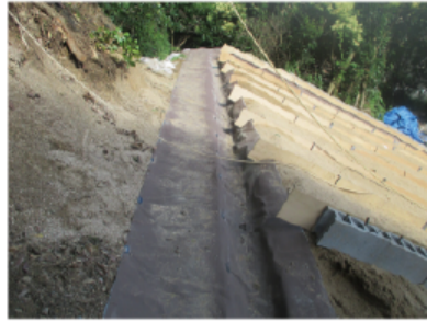
法面 小段排水工
