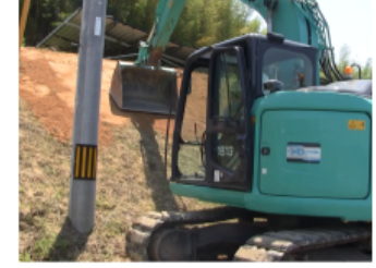
法面整形状況
