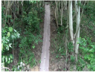
法面 縦排水工
