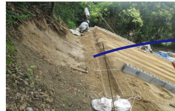
法面 小段排水溝
