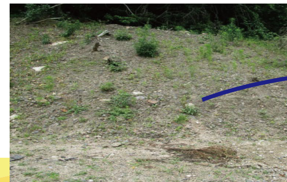
法面 縦排水溝
