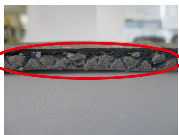
硬化後の断面状況
