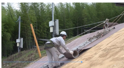
① マット設置
