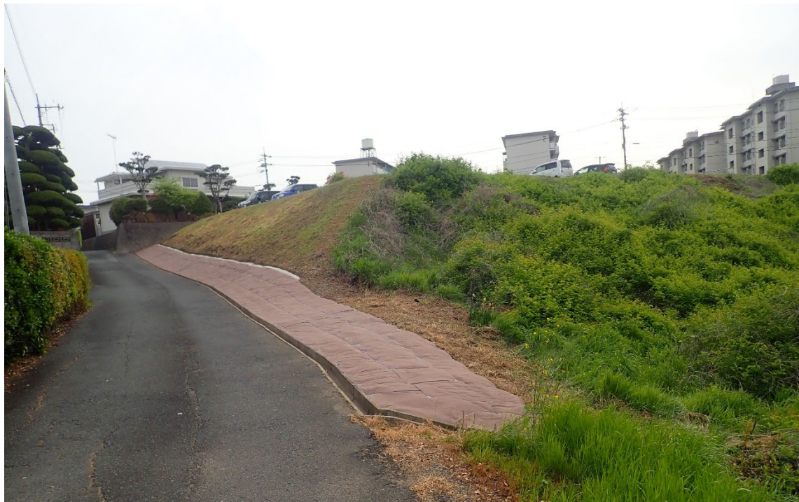
横張りによる防草 84 m 2
