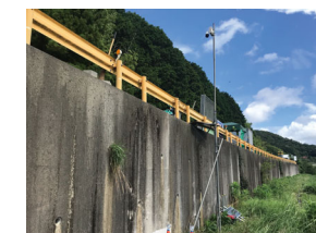
カメラ設置状況
