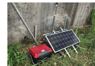
ソーラー・蓄電池
