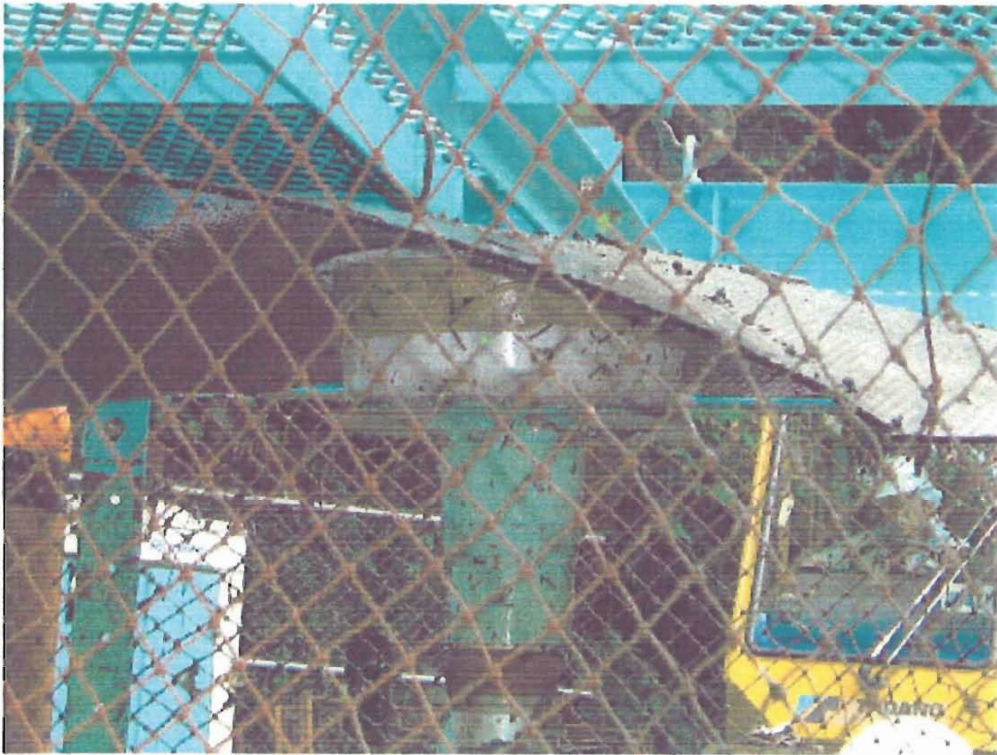
写真4-8 取水口形状の変更（取水口高さを水面3~5cm程度の表層に限定。取水口上蓋を取外し、円盤状の広がりを持つものを取付けた。）
