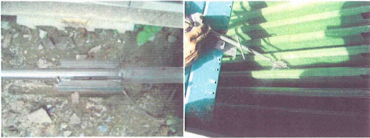
写真 4 - 2 高圧水洗浄状況
