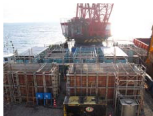
装置の設置状況
